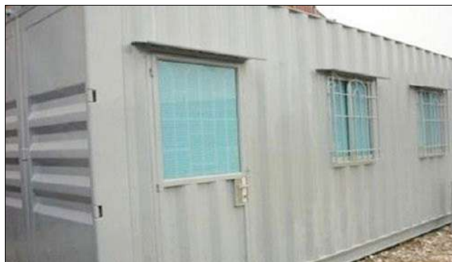
Hình 1.5. Hình ảnh nhà điều hành có kết cấu bằng thùng container
